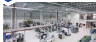
Ausbau der Produktion mit einer neuen, 13.000 m 2 großen Fertigungshalle in Metzingen
